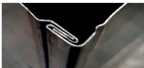
Fig. 2a Îmbinare cu falț longitudinal tip NU-LOK și dimensiuni (mm)
