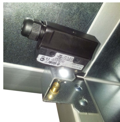
Microinterruttore ispezione ventilatore Microswitch fan's protection
