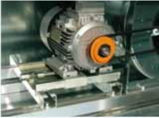
Motori montati su slitte tendicinghia con regolazione a vite senza fine. Trasmissione a cinghie e pulegge con calettatori conici
