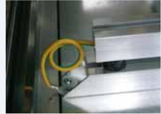
Dispositivi di sicurezza: carter di protezione e/o microinterruttore sulla porta d'accesso alla sezione ventilante, vite metrica inox di messa a terra per ogni sezione, ponti per la equipotenzialità fra le apparecchiature elettriche ed il telaio della macchina
