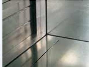
Superficie interna liscia per ridurre il ristagno di polveri e facilitare la manutenzione e la pulizia
