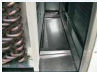
Batterie di scambio termico (anche con certificazione ARI):
